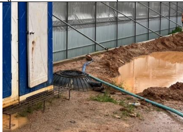
รูปที่ ๗.10 ถังบำบัดน้ำเสียสำเร็จรูป
